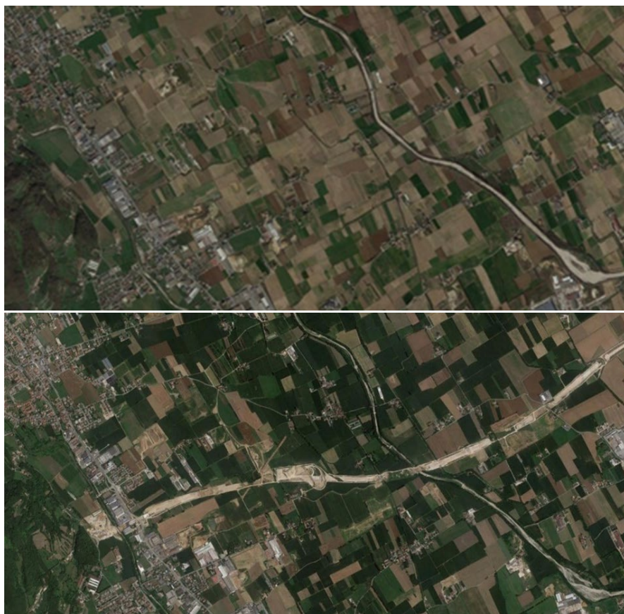
Cantieri stradali per la Pedemontana Veneta nel comune di Malo (VI); immagine 2014 in alto, 2016 in centro, 2020 in basso. Tra il 2014 e il 2020 i cantieri della Superstrada Pedemontana Veneta, hanno occupato circa 580 ettari tra le province di Treviso e Vicenza. Fonte: ISPRA-SNPA 2021
