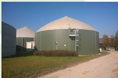
Impianto di biogas
