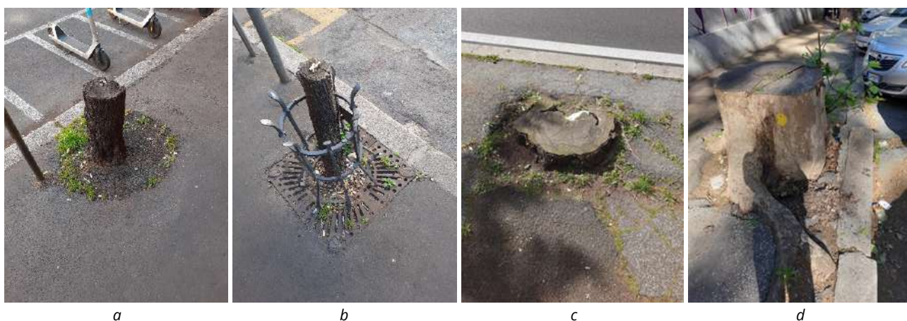
Figura 5.9 - Esempi alberi abbattuti e non ancora sostituiti, di cui è ancora visibile la ceppaia morta che sarà necessario rimuovere nel momento della nuova messa a dimora (a - Via Giuseppe Ferrari, Prunus sp.; b - Via del Gazometro, Hibiscus syriacus ; c - Viale Guido Baccelli, Cupressus sempervirens ; d - Via Satrico, Platanus hybrida ).
