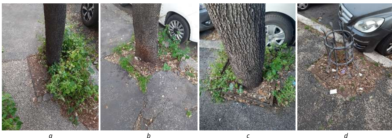
Figura 5.15 – Formelle con cordoli in ferro, grate e gabbie per Quercus ilex a Via Eustachio Sebastiani (Monteverde): albero con dimensioni compatibili alla formella (a); progressivo indebolimento strutturale della cornice in ferro (b) e successivo scalzamento (c) col progredire della crescita radiale degli alberi; pianta da sostituire per effetto di una protezione risultata nel tempo inadeguata alla crescita della pianta (d).
