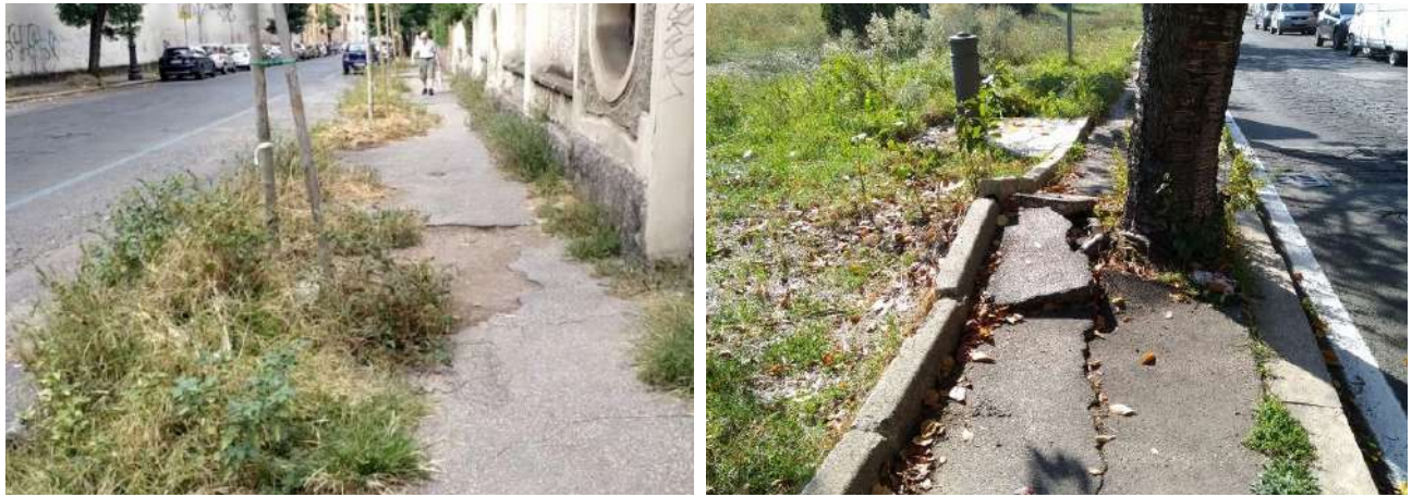
Figura 3.3. Aspetti critici per la viabilità pedonale riscontrabili in alcune vie di Roma.
