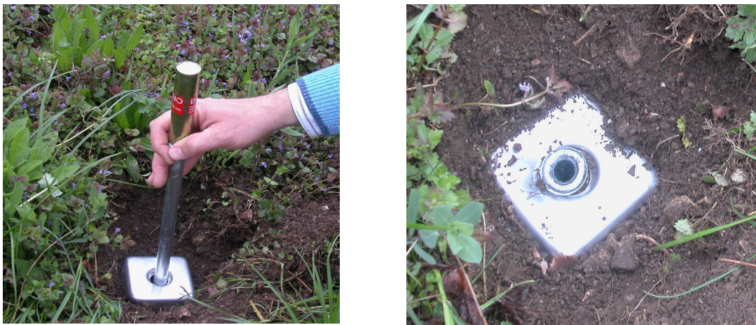
Fig. 2.13 L’interramento del picchetto permanente di fase 3 (con l’uso del batticippo) e il picchetto completamente interrato.
