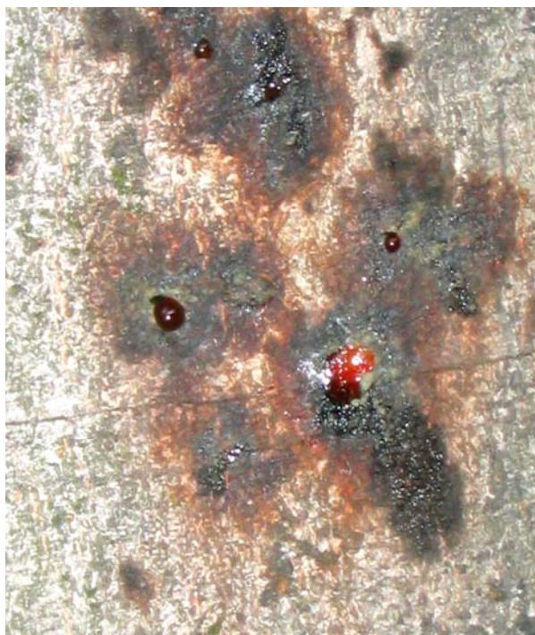
Fig.17 – Tipologia di danno. Cancro.
