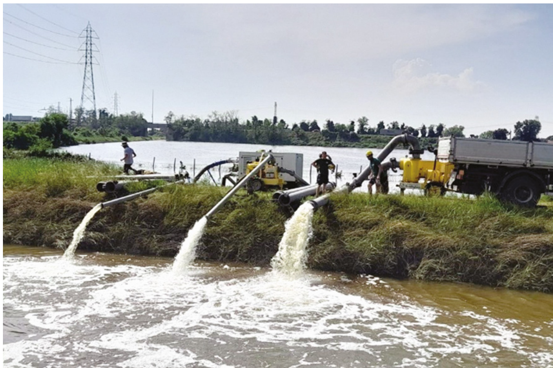
FIG. 12.3 - POMPE MOBILI INSTALLATE A SUPPORTO DELLA GESTIONE EMERGENZIALE
